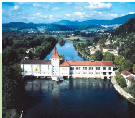
Frontansicht des IBAarau Wasserkraftwerks in Aarau
